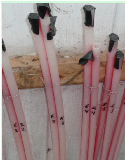
Tuyaux chauffants intégrés aux planchers des serres.
